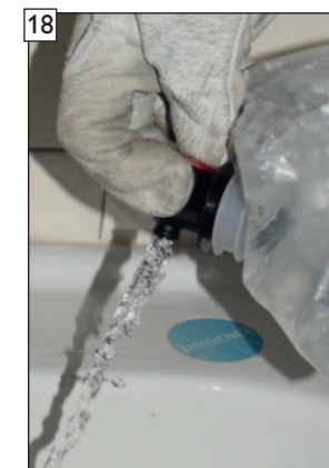
18 Durch Drücken der Entrie- gelung (rote Entriegelungs- taste) am BIB-Anschluss- hahn kann der Kondensat- auffangbeutel tropfsicher entleert werden.
