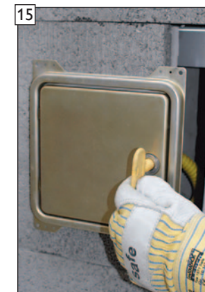
15 BlowerDoor Kondensat- blendentürblatt abnehmen.
