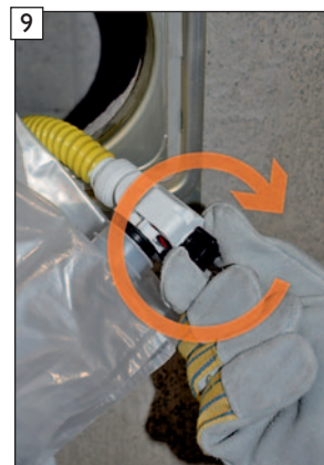
9 Verriegelung des BIB-Con- nectors im Uhrzeigersinn schließen.
