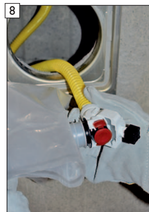
8 BIB-Anschlusshahn des Kondensatauffangbeutels in die Aufnahme des Kupp- lungsteils vom BIB-Con- nector einstecken.
