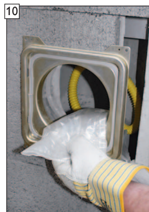
10 Siphonschlauch und Kon- densatauffangbeutel in Schornsteinfuß einschieben.
